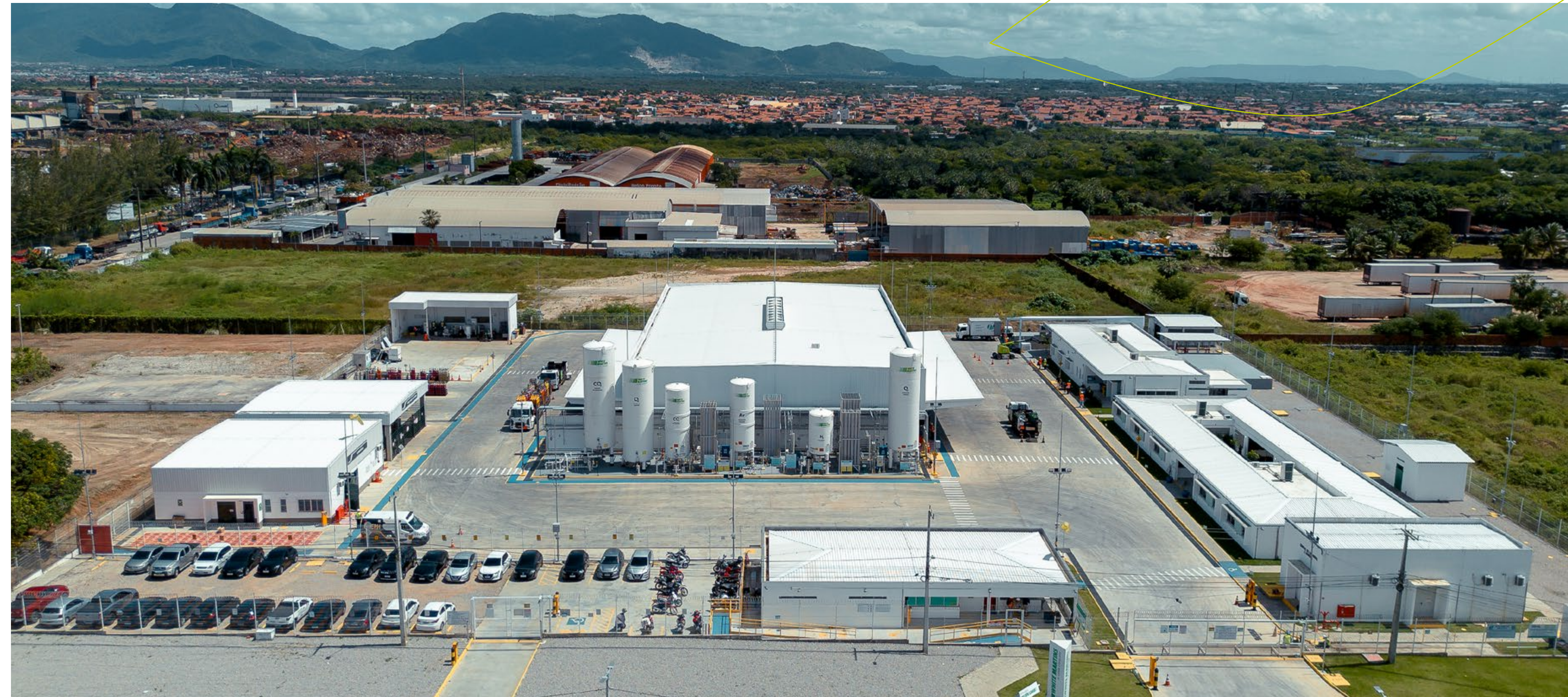
Unidade de enchimento de cilindros de Maracanaú (CE)
