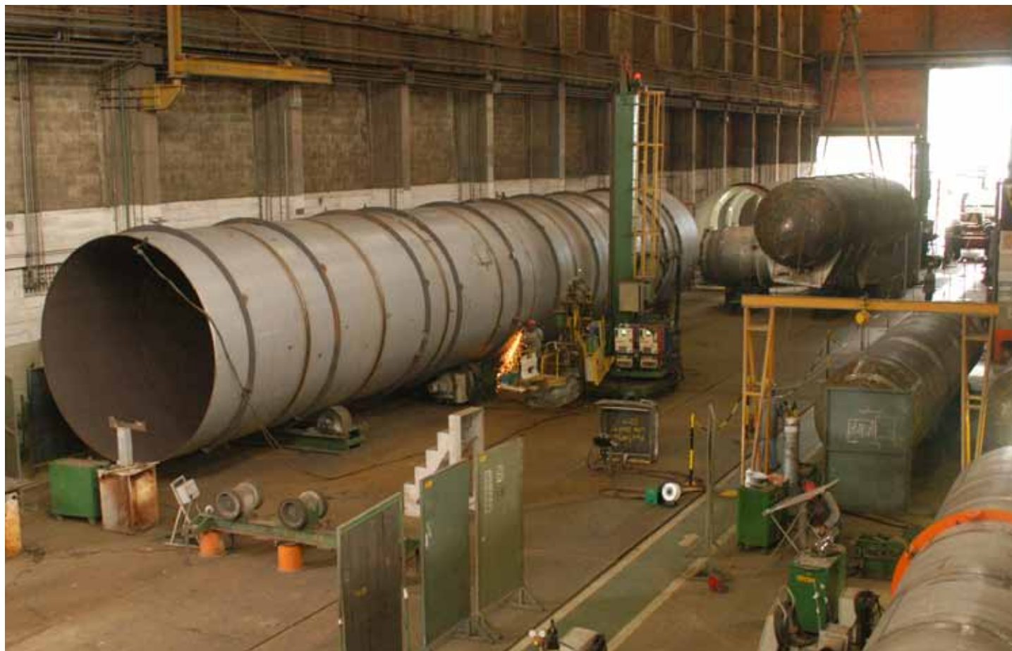
Construção e solda de tanques na Fábrica de Equipamentos Criogênicos (RJ)
